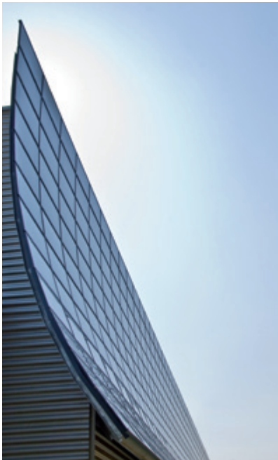
Solarfassade aus Dünnschichtzellen am Ferdinand-Braun-Institut (oben) Gläsernes Blockheizkraftwerk (unten)
