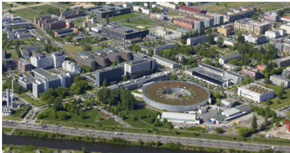
Elektronenspeicherring BESSY II am Ernst-Ruska-Ufer (2013)
