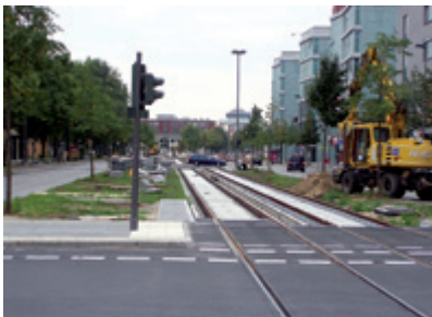
Bauarbeiten Rudower Chaussee (2008)
