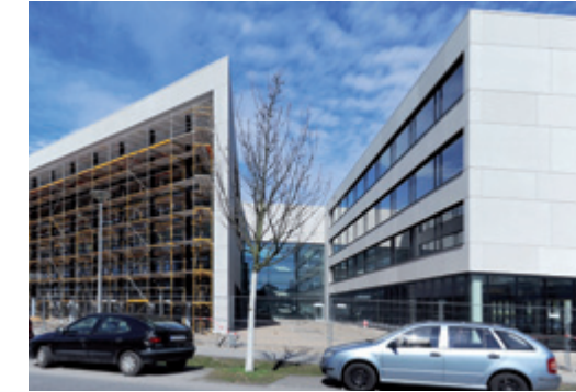
Zentrum für IT und Medien ZIM3 (links) Zentrum für Photovoltaik (rechts)
