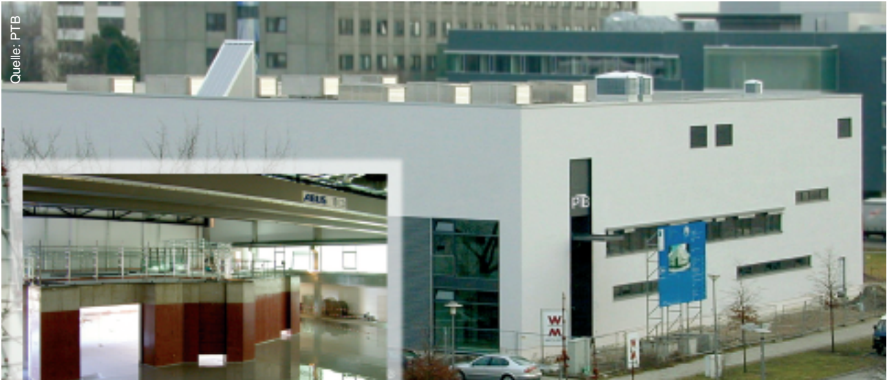
Das Willy-Wien-Laboratorium der PTB neben BESSY II in Adlershof und der Strahlenschutzbunker in seinem Inneren, der die Metrology Light Source aufnehmen wird.
