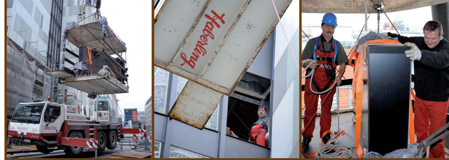
↑ Das Labor der Humboldt-Universität zieht von Mitte nach Adlershof. Dafür werden optische Tische mit einer Kranpalette aus dem Fenster gehoben.
