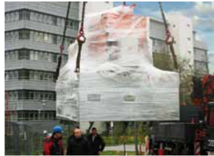
↑ Das Herzstück des neuen Biogas-Blockheizkraftwerkes wird geliefert: der 12-Zylinder-Gasmotor
