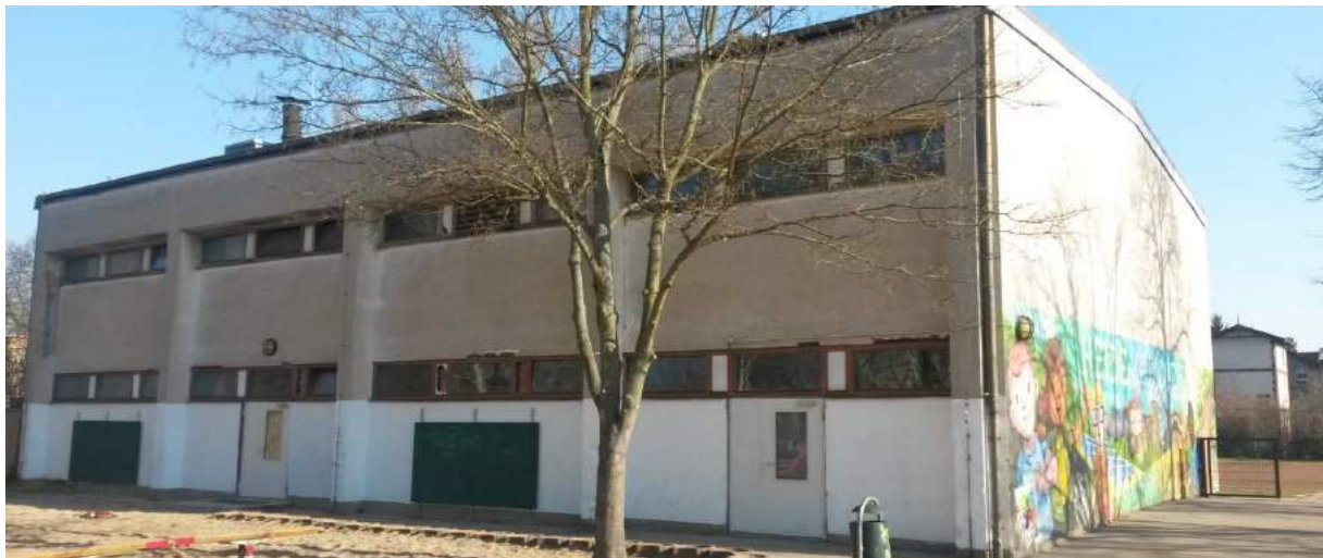
Abbildung 38: Heide-Grundschule – alte Turnhalle
