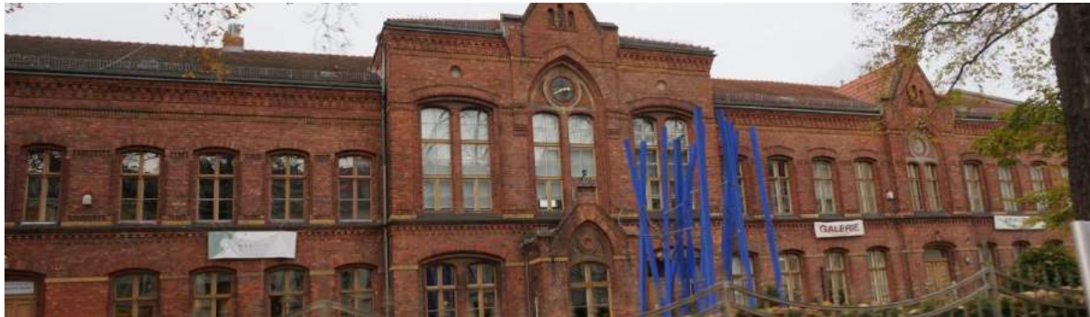
Abbildung 37: Kulturzentrum Adlershof „Alte Schule“
