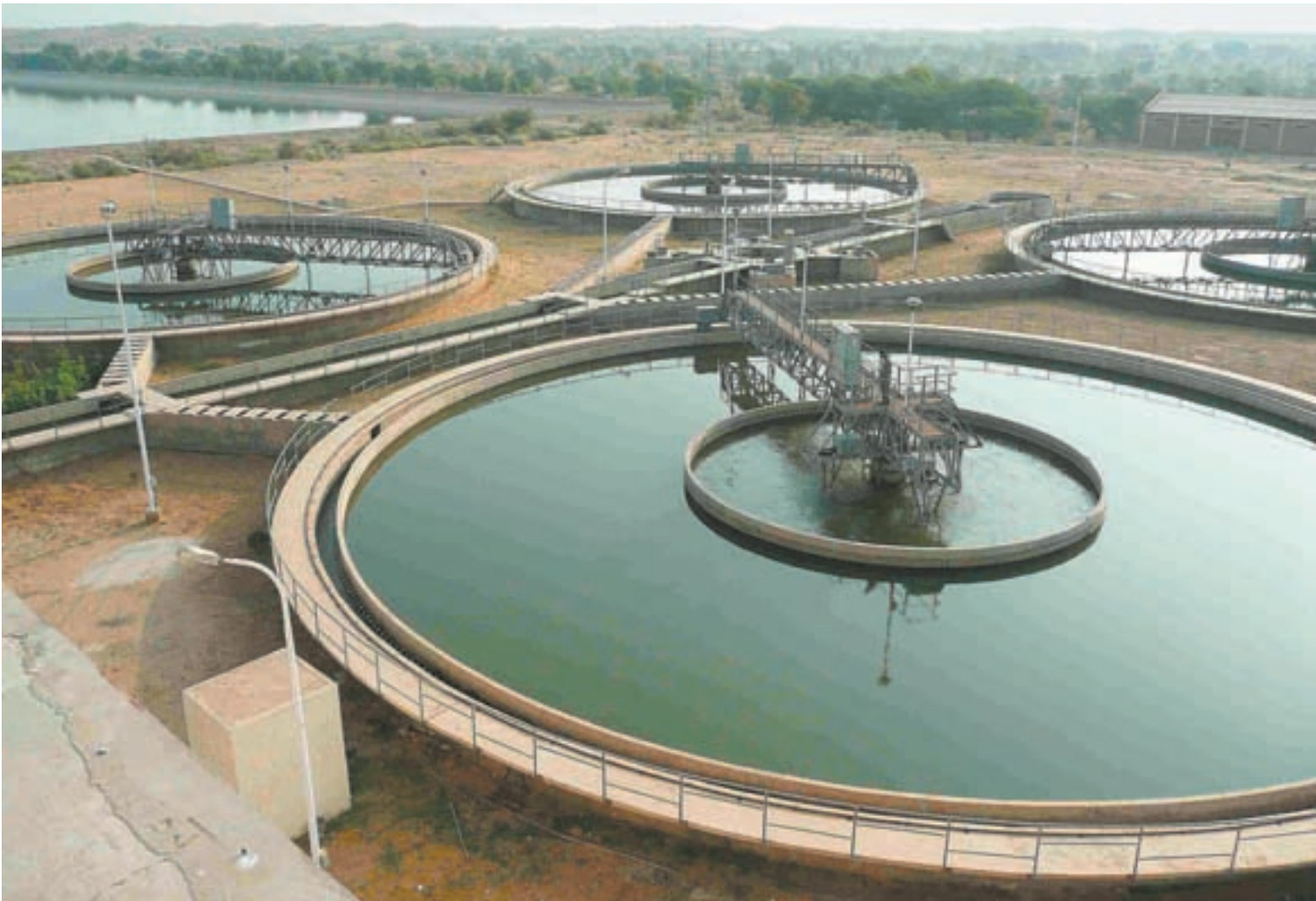
Indien arbeitet mit Technik von Berlinwasser International: Das Nachklärbecken in Dhanasar in Rajasthan reinigt das dringend benötigte Wasser. Das Bild unten zeigt die archimedische Schraube am Einlaufbecken einer Kläranlage in Nanchang, China
