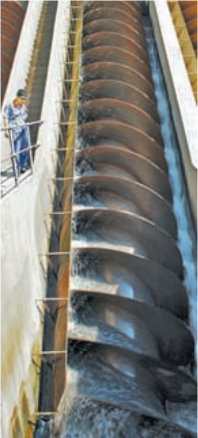
Indien arbeitet mit Technik von Berlinwasser International: Das Nachklärbecken in Dhanasar in Rajasthan reinigt das dringend benötigte Wasser. Das Bild unten zeigt die archimedische Schraube am Einlaufbecken einer Kläranlage in Nanchang, China
