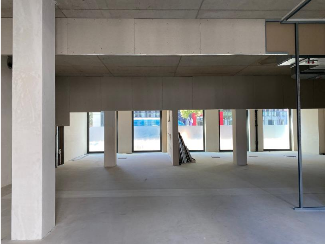
EG rechts / Bereich 2 Teilweiser Trockenbau mit Blick zur Straße Am Studio 26
