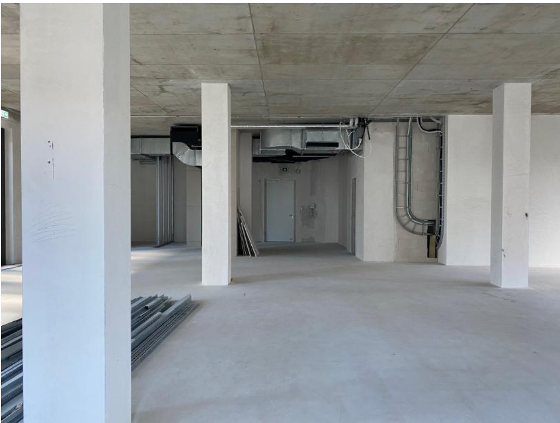
EG rechts / Bereich 3 Innenbereich mit Übergang zu Bereich 2
