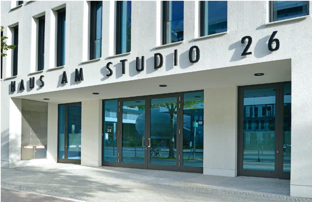
Am Studio 26 | Fassadenansicht mit zwei separaten Eingängen für das EG links und EG rechts
