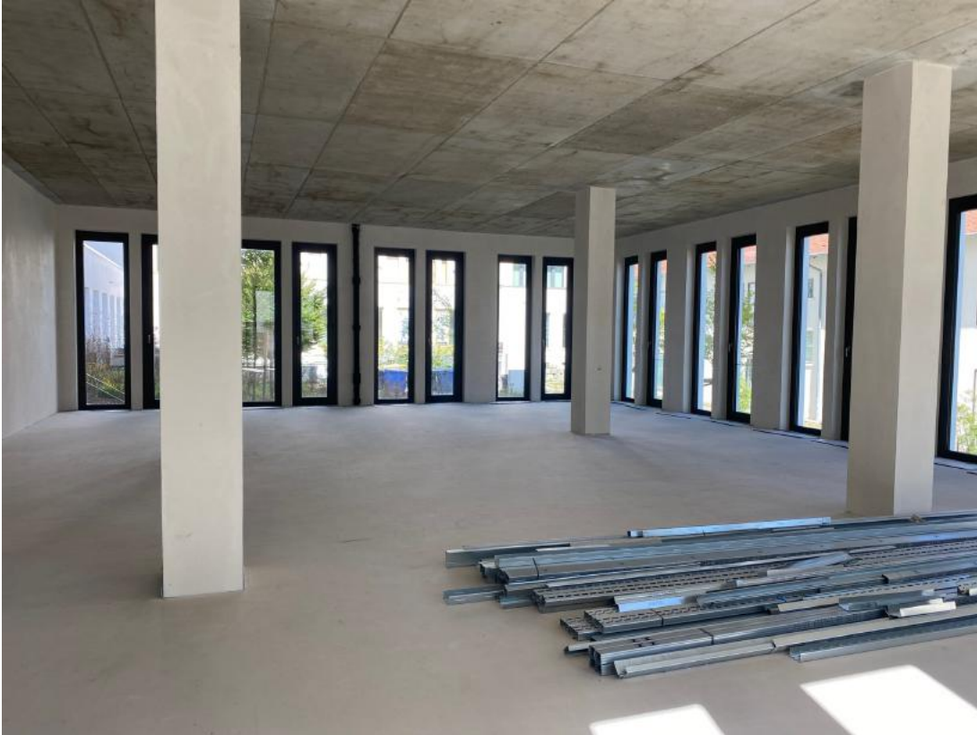
EG rechts / Bereich 3 Innenbereich mit Blick zum Hof
