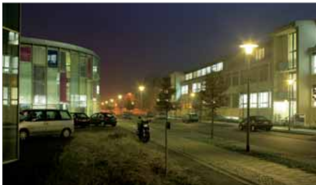
Büro- und Laborgebäude in der Schwarzschildstraße, Ende 60er Jahre Heute, links: Zentrum für Photonik und Optische Technologien
