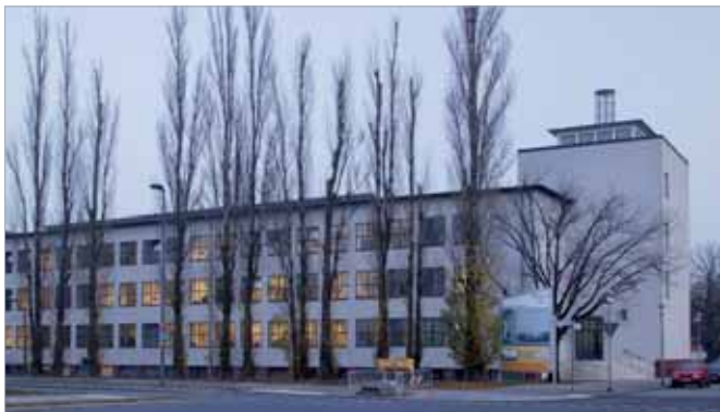
„Eingangsbereich Süd“ der Akademie der Wissenschaften der DDR, Rudower Chaussee, 80er Jahre Heute: WISTA-Hauptgebäude
