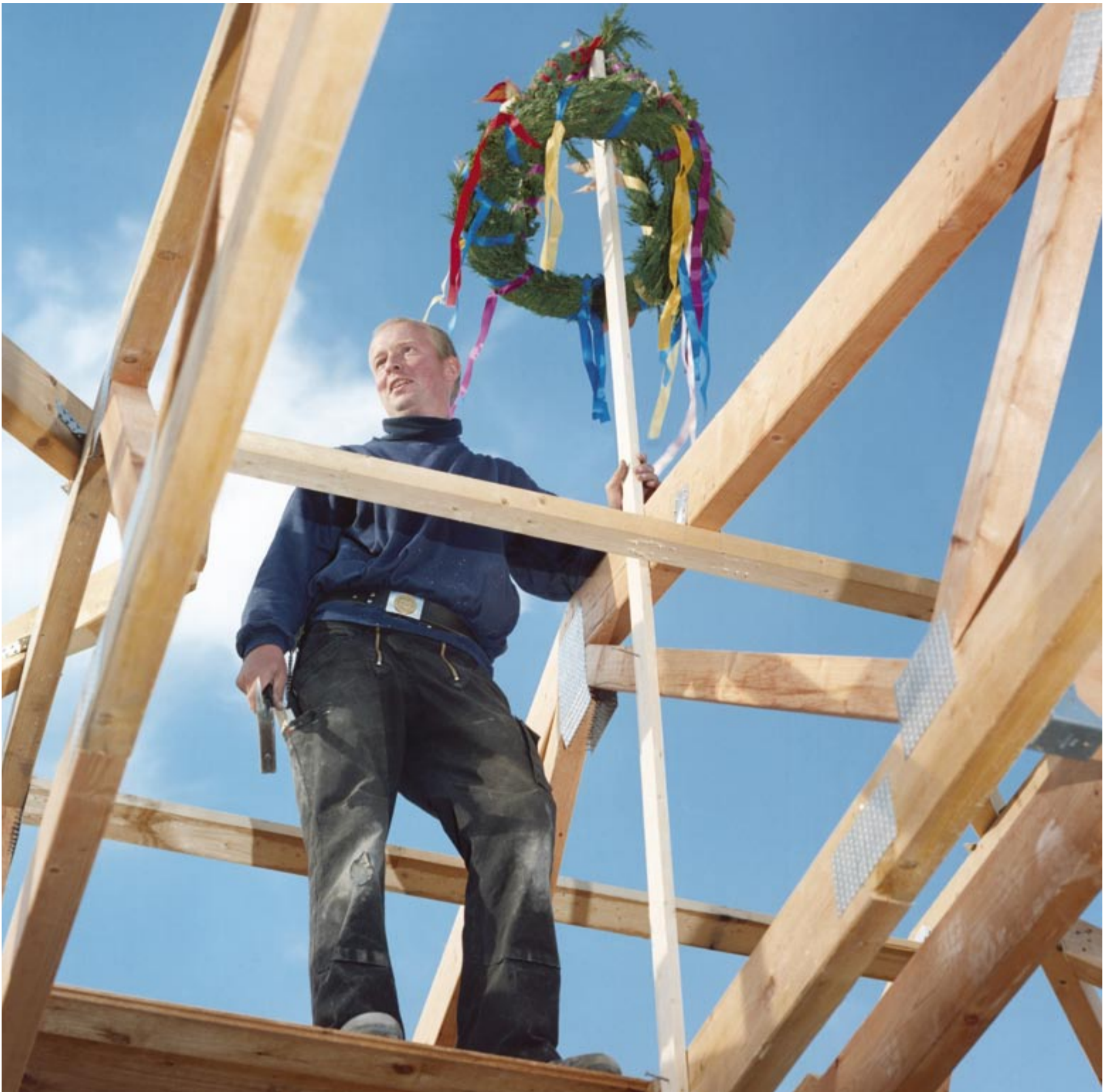
Zimmerer bei einem Richtfest im Gebiet „Wohnen Am Landschaftspark“.
