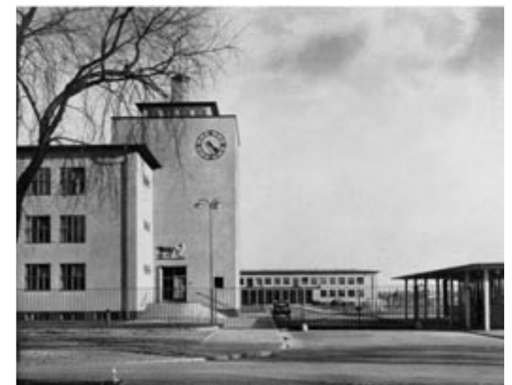
Eingang zum Hauptgebäude der DVL, Mitte der Dreißigerjahre (Architekten Hermann Brenner und Werner Deutschmann).
