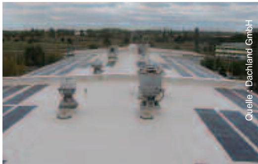
Innovative Dacheindeckung auf dem Photonikzentrum
