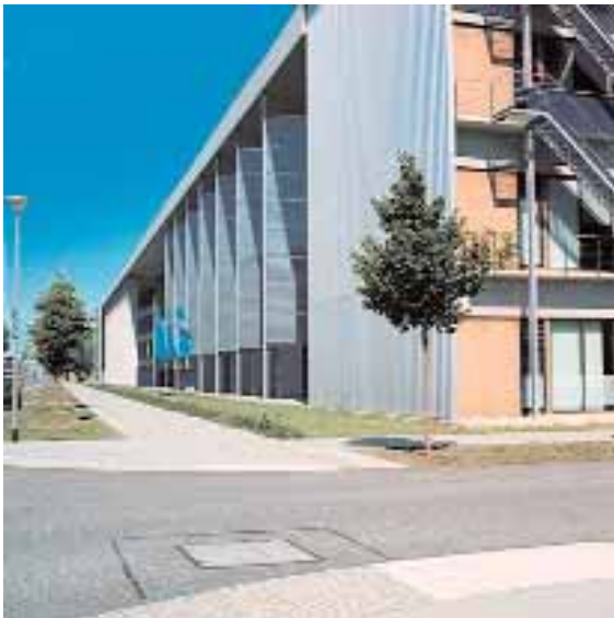
SOLON-Module sind an der West-Fassade des UTZ nach optimaler Sonnenausrichtung in die dem Gebäude vorgelagerten Verschattungsstelen integriert.
