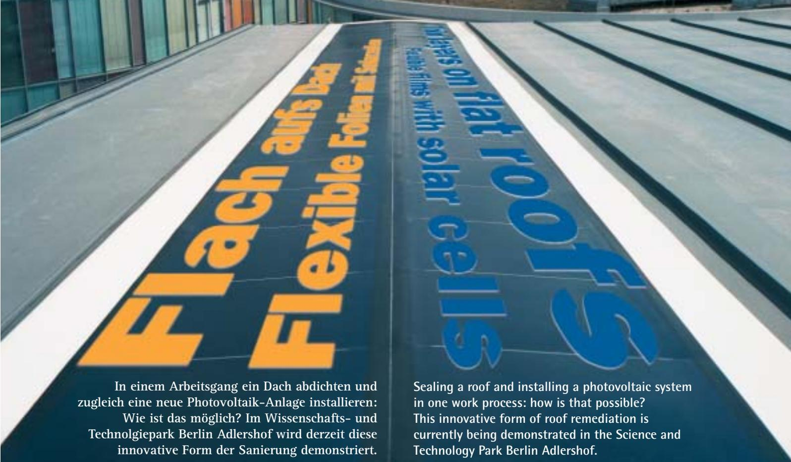
In einem Arbeitsgang ein Dach abdichten und zugleich eine neue Photovoltaik-Anlage installieren: Wie ist das möglich? Im Wissenschafts- und Technologiepark Berlin Adlershof wird derzeit diese innovative Form der Sanierung demonstriert.
