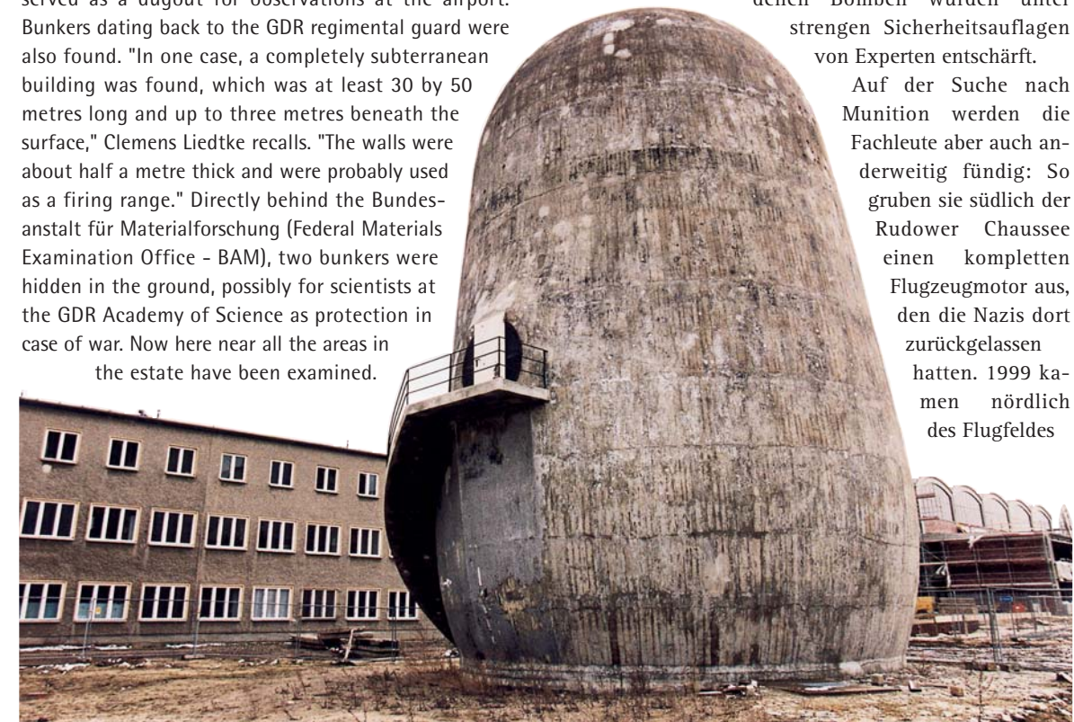
► Zeuge der Vergangenheit: Einst wurden in diesem Trudelturm Flugzeugmodelle unter extremen Bedingungen getestet.
