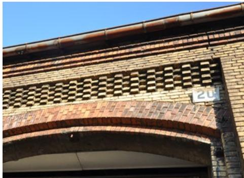
Die Klinkerstruktur ist weitgehend erhalten und wird bei der Sanierung originalgetreu hergestellt.
