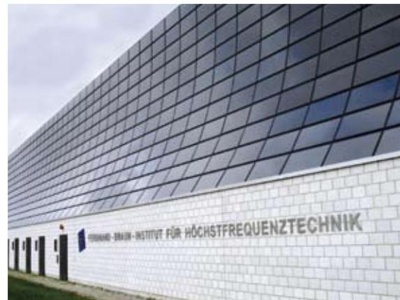
↑ Die Fassade des Ferdinand-Braun-Instituts ist eine der ersten großflächigen Anwendungen der in Johannisthal/Adlershof entwickelten Dünnschichtsolarmodule auf Schwefelbasis
