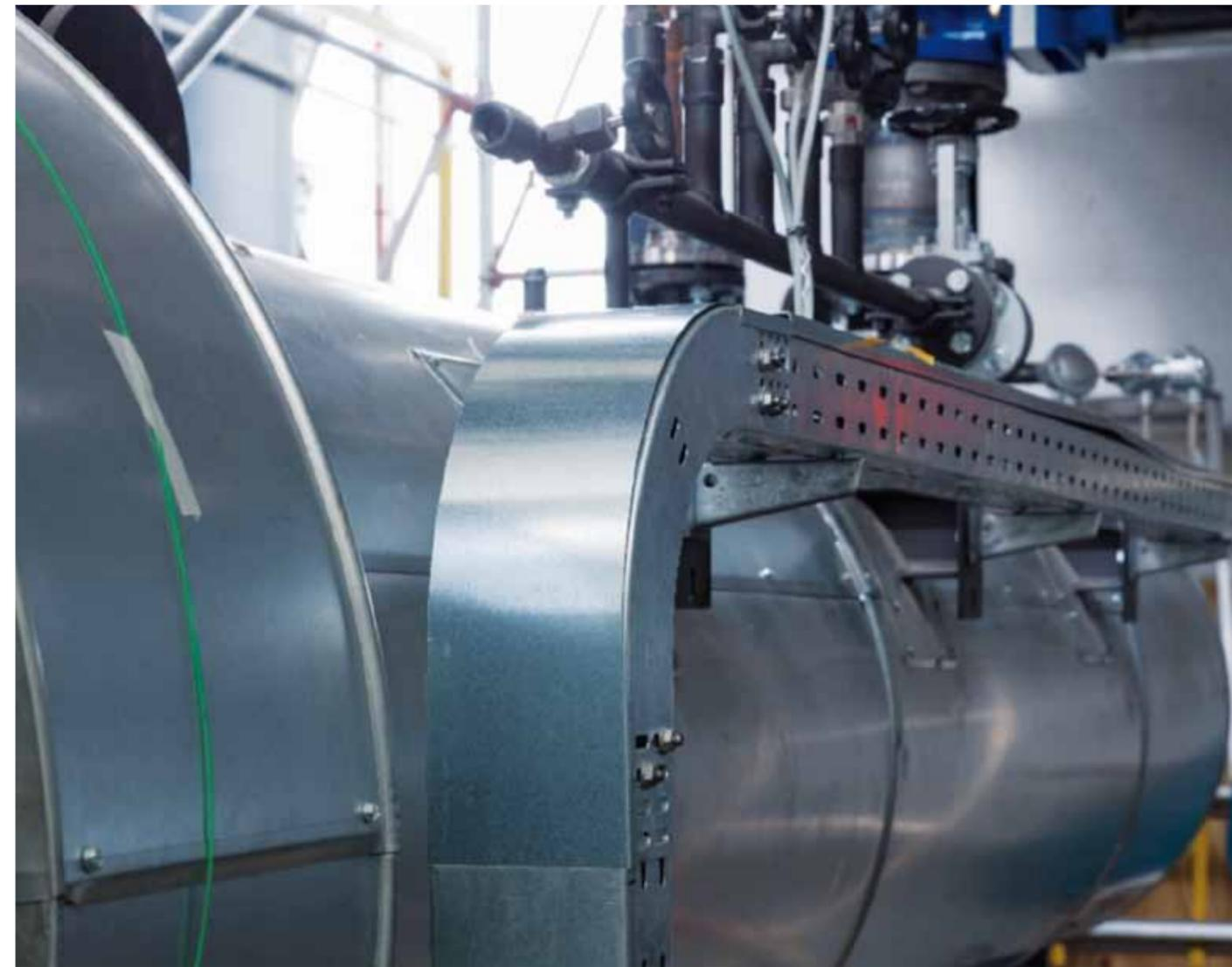
Blick auf einen der beiden Rohrheizkörper mit einer Leistung von jeweils 3 MW
