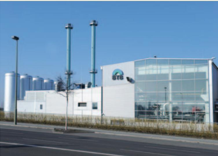
**Abb. 6** Das 1966 erbaute Heizkraftwerk wurde 1992 von der BTB bei laufendem Betrieb saniert. Ein BHKW mit Gasturbine, fünf Gasmotor-Generator-Aggregaten und vier Heißwassererzeugern sorgt seitdem für eine effiziente Strom- und Wärmebereitstellung. Quelle: WISTA-MG
